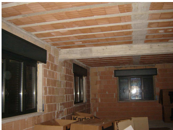
Foto 5 - VISTA INTERNA PIANO TERRA
