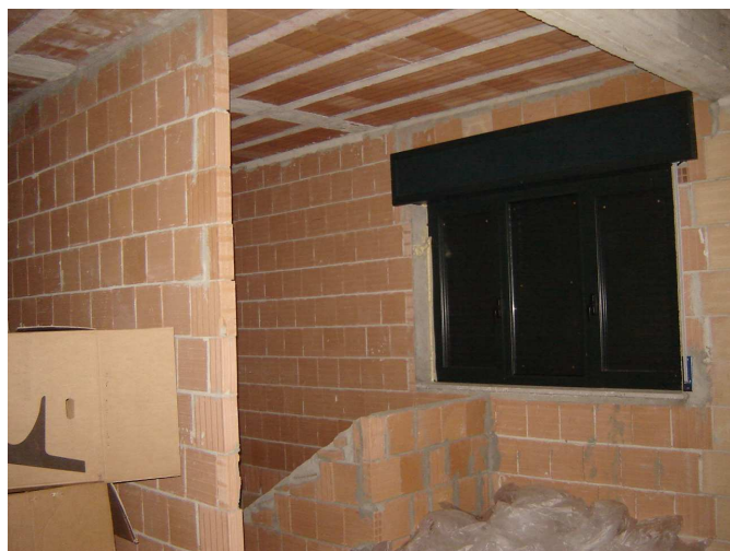
Foto 6 - VISTA INTERNA PIANO TERRA
